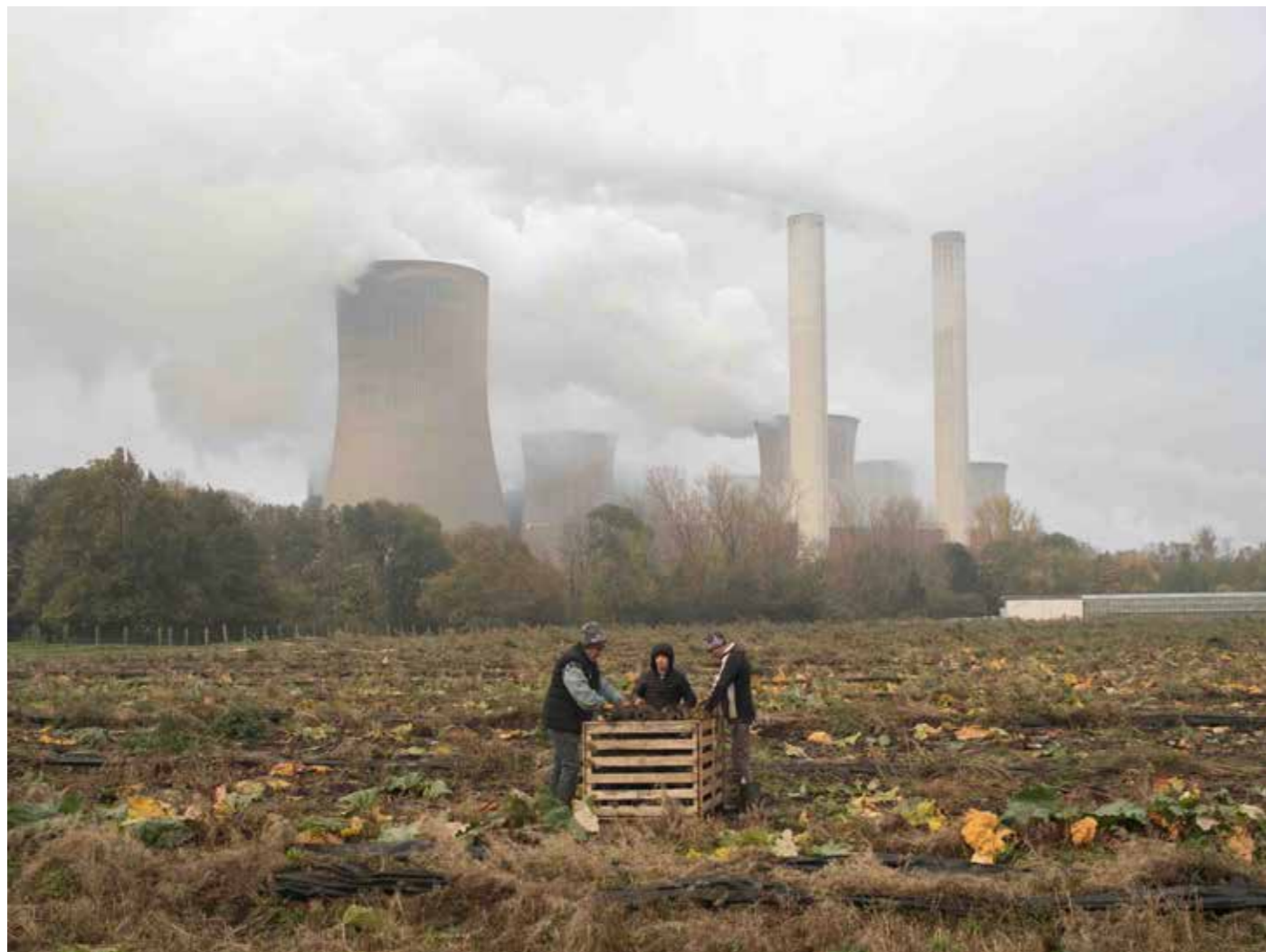
Bergheim, Allemagne. Niederaussem Power Station, centrale électrique au lignite appartenant à RWE. © Rocco Rorandelli
