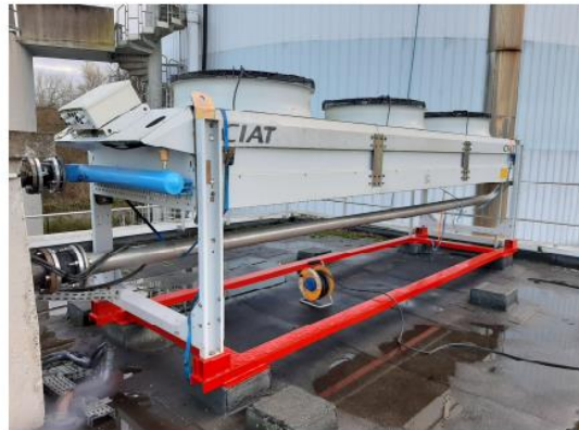
Pose nouvel aéroréfrigérant
