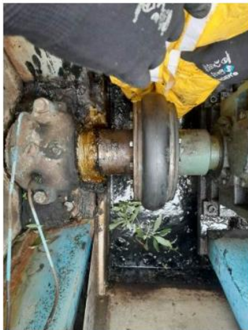
Remplacement accouplement pont brosse n°1
