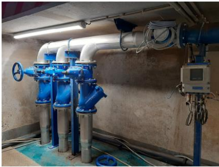
Réhabilitation poste toutes eaux
