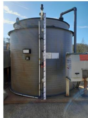
Pose de l'échelle de mesure limnimétrique
