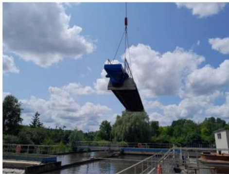
Réparation du pont brosse n°3
