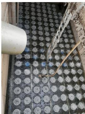
Remplacement des disques membranaires du Biomaster (Traitement graisses)
