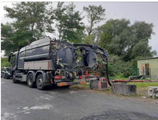
Installation d'un pompage provisoire (bypass) du poste général et curage complet du poste
