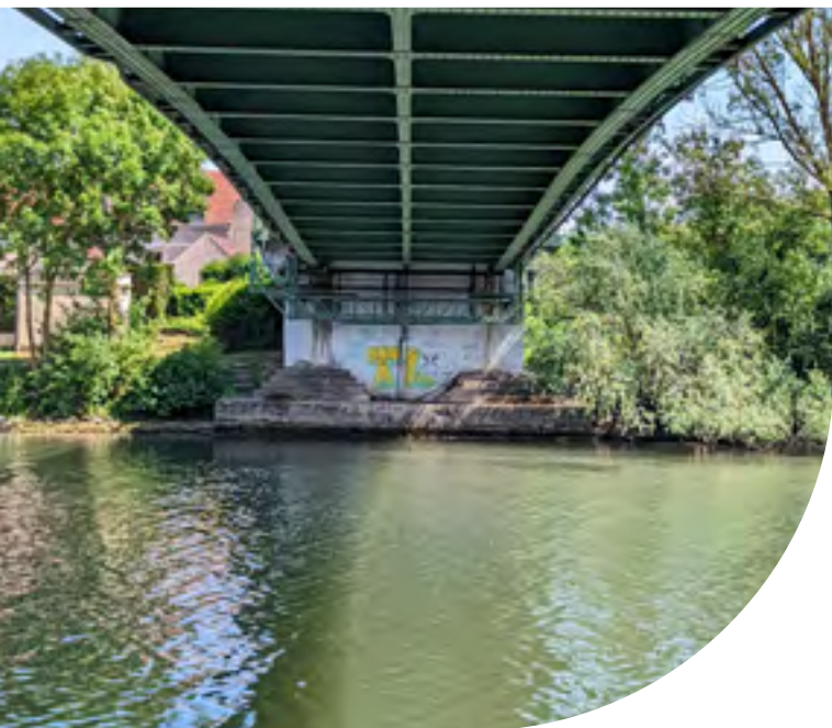
Pont reliant Saint-Leu d'Esserent à Saint-Maximin
